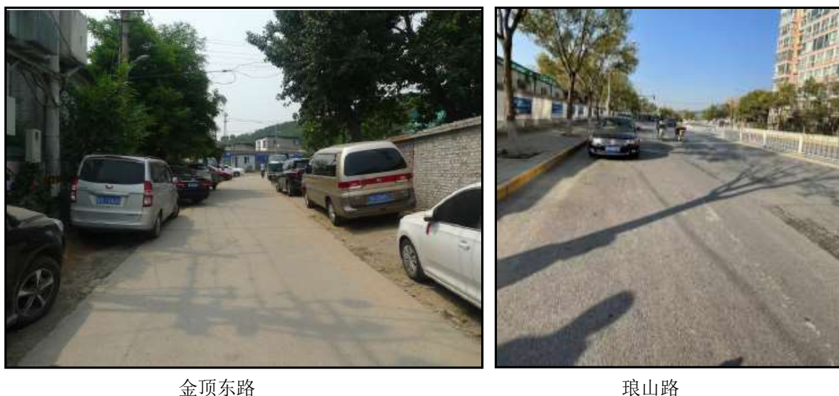
图 3-1 项目地块周边道路现状照片
